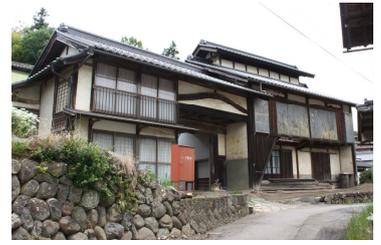
出桁造りとは、軒を深く出すために、垂木をささえる桁を胴差よりも外に出した納まりのこと。出し桁は、桁を化粧材とするために、すべて鉋仕上げとなり仕口も重なりが見える。そのために丁寧な仕事が要求されて、大工仕事が格段に厄介になる。出し桁は重厚な雰囲気になるので、商家などで用いられた。
