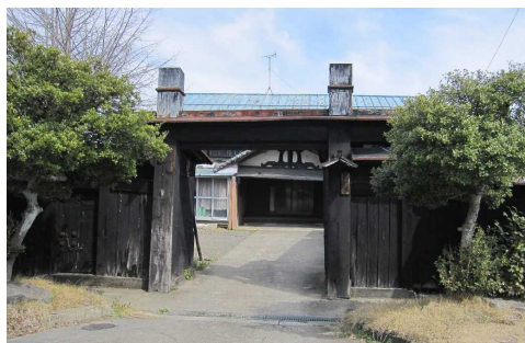
現在の稲荷山本陣跡
